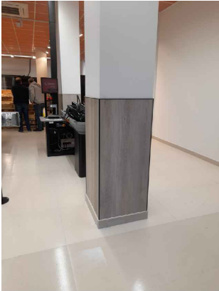
FOTO REVESTIMIENTO PILARES
